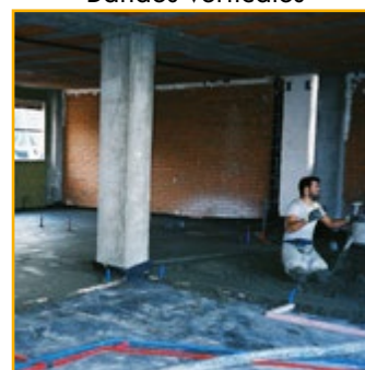
Verser le mortier
