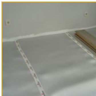
Poser et fermer les joints
