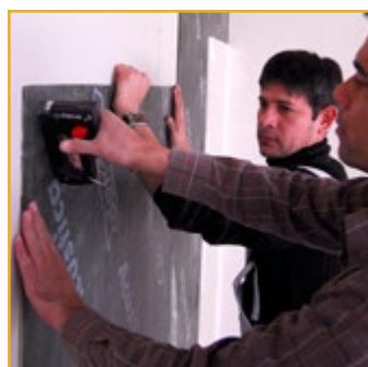
Agrafer sur la première plaque (mur)
