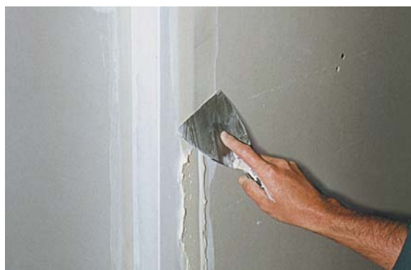
Lissage de l'enduit après pose de la bande Ultraflex (angle sortant)
