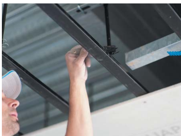
Mise en place des suspentes
