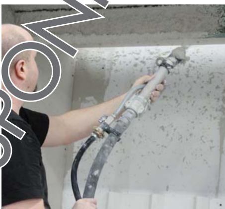
Application de l'enduit sur poutre
