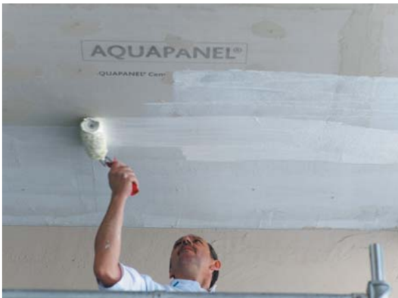
Traitement des têtes de vis
