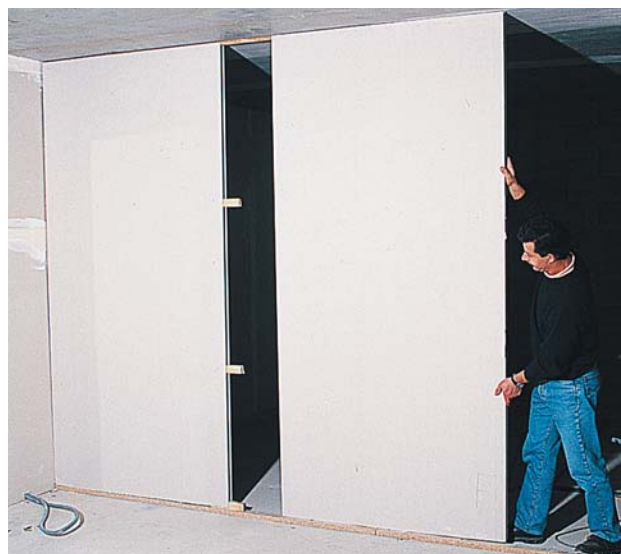
Fig. 2 : Jonction entre deux cloisons
