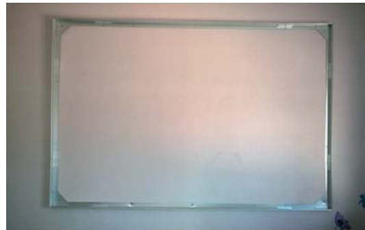
Positionner et fixer le reste des profilés
