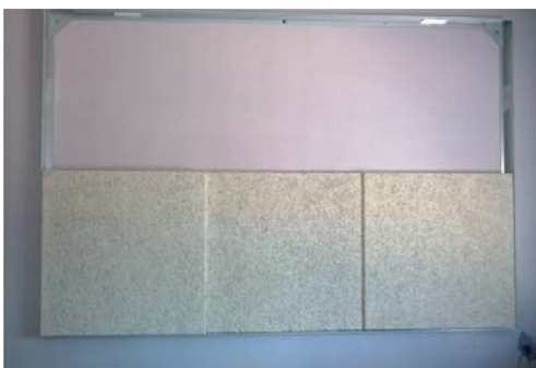
Positionner et fixer le reste des panneaux
