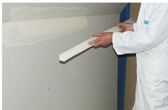
Pose de la bande Ultraflex (angle rentrant)
