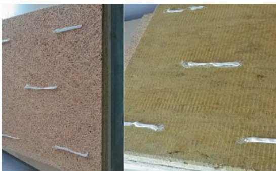
Encoller le dos des panneaux avec 5 cordons de 15 cm
