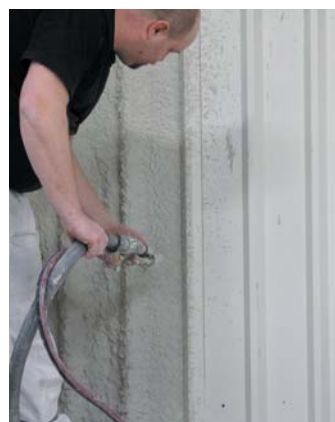
Application de l'enduit sur tôle
