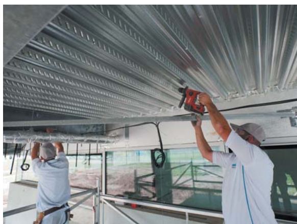
Mise en place des suspentes
