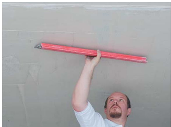
Application de l'enduit d'armature plafond
