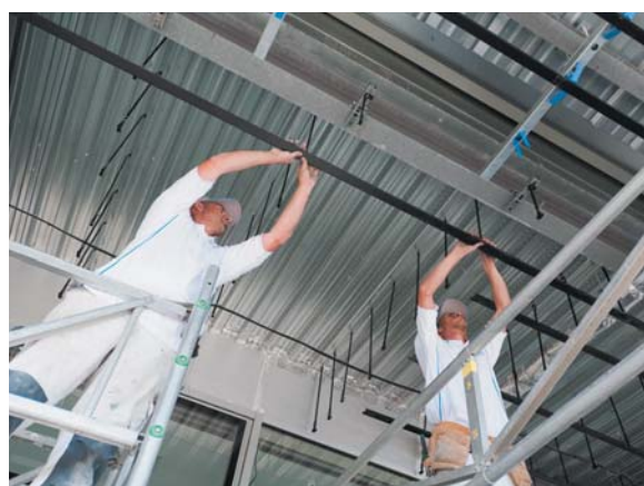
Réglage des suspentes
