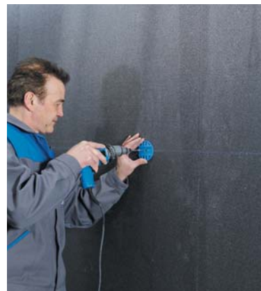
Visser la cheville SDF-S au travers de la platine.
