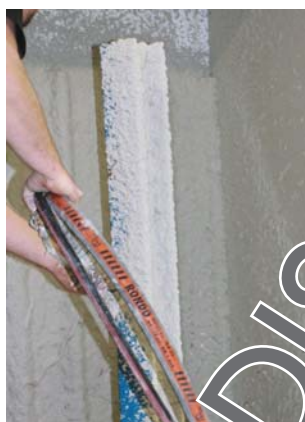
Application de l'enduit sur poteau
