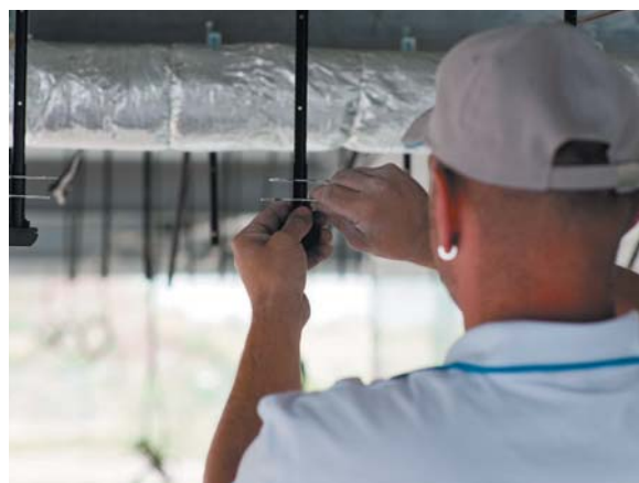
Réglage des suspentes
