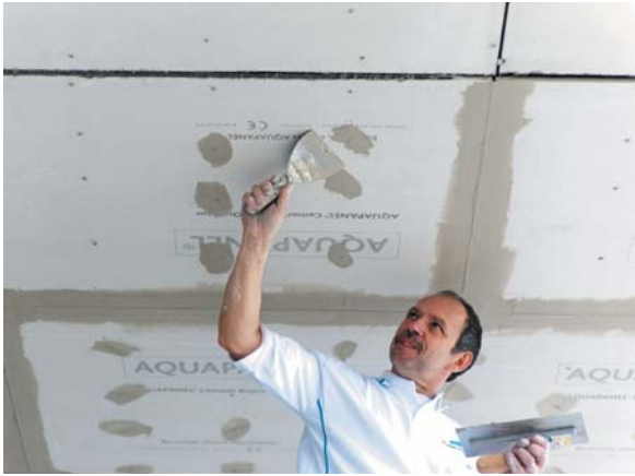
Traitement des têtes de vis
