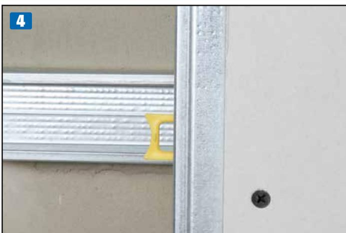
Solutions et systèmes de fixations réglables pour le doublage des murs sur ossature métallique.
